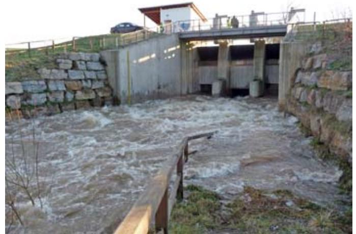
Abb. 6: Beckenabfluss nach Probestau
