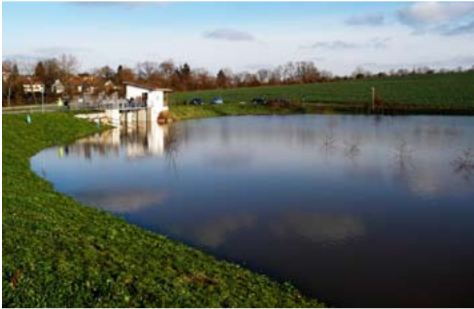
Abb. 1: HRB Cappel (eingestaut) mit Steuerbauwerk
