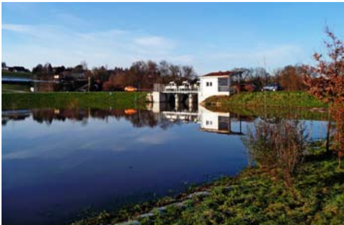
Abb. 5: eingestautes Becken beim Probestau
