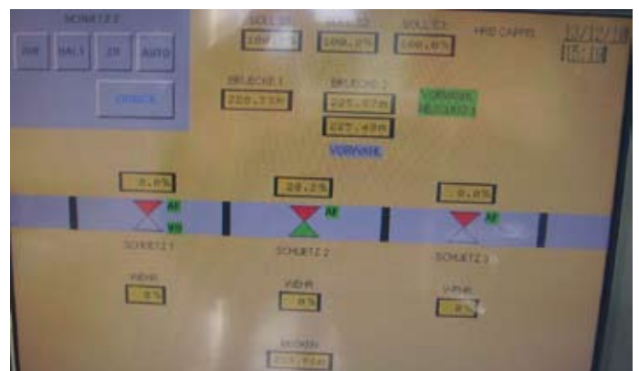
Abb. 4: Ansicht Kontroll- und Steuerdisplay
