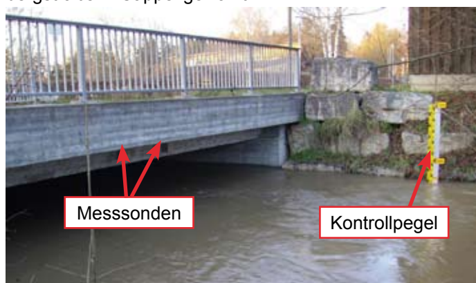
Abb. 2: Brücke Hornbergstraße in Cappel
